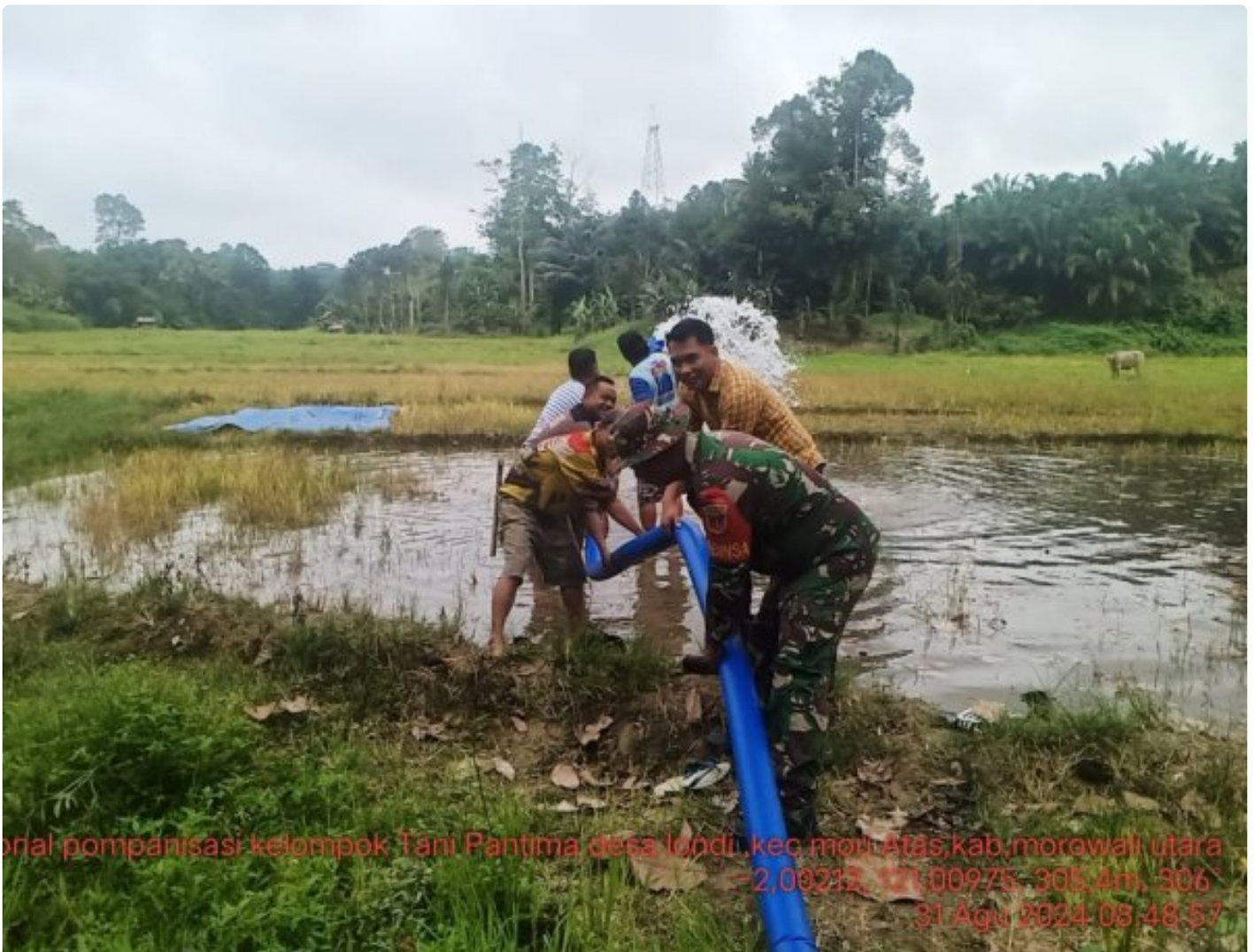
Serka Nasruddin bantu pendampingan pemasangan pompanisasi
